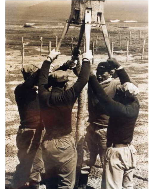
防風垣の杭打ちの様子
