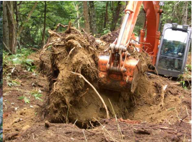
写真 2 根返しプロットの施工風景
