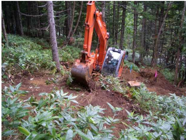
写真 1 地がきプロットの施工風景
