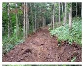
図 - 3 切土量を 極力少なくなるよ うに作設
