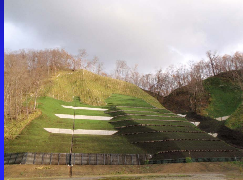
木製法枠工(東大雪支署)
