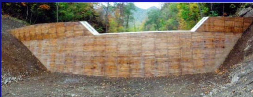
残置式丸太型枠
