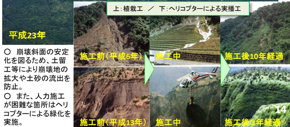
○ 崩壊斜面の安定化を図るため、土留工等により崩壊地の拡大や土砂の流出を防止。
