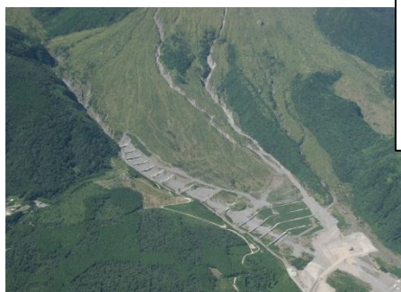
水無川流域 治山ダム群の設置 (平成18年撮影)
