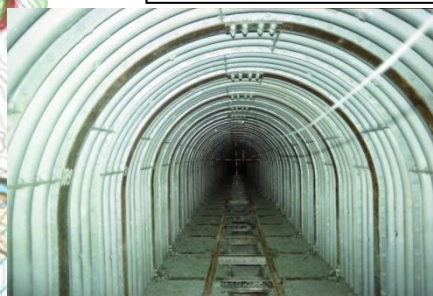
排水トンネル施工状況
