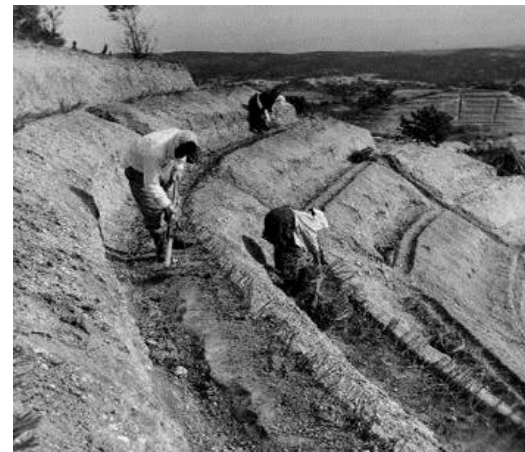
施工状況（昭和中期）
