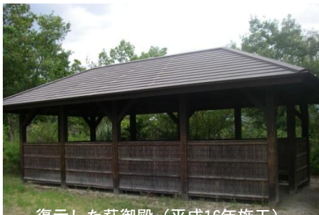
復元した萩御殿（平成16年施工）
