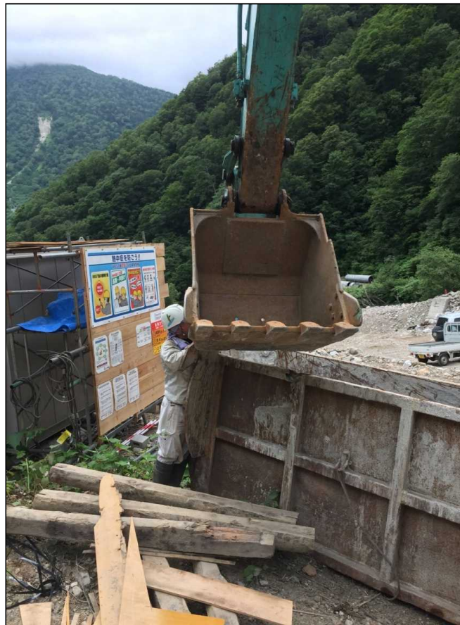
オペレーターからはバケットで隠れて右手の状況が見えない
