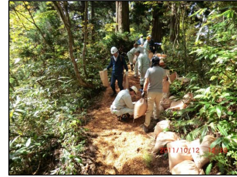
スギチップ敷設作業(美女平)
