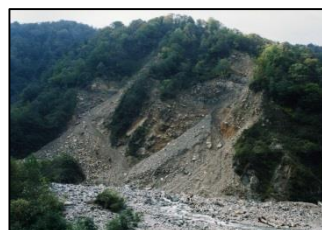
山腹工事施工前
