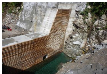
丸太残存型枠(スゴ谷地区治山えん堤)
