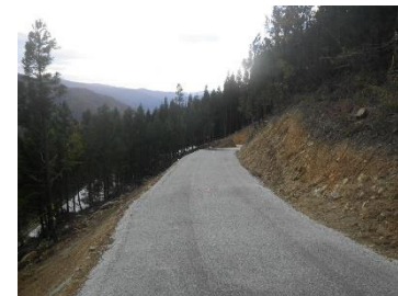
三本松割林業専用道(工事完成)
