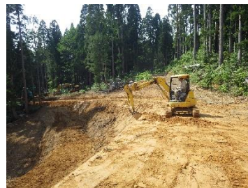
千軒平林業専用道(工事中)
