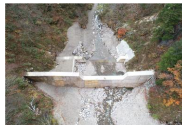
丸太残存型枠(スゴ谷地区治山えん堤)
