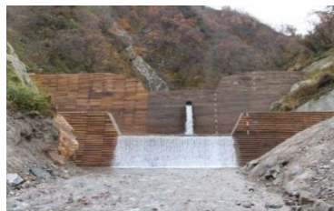
国産丸太残存型枠を利用した谷止工
