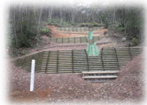
(間伐材を利用した校倉式土留工)
