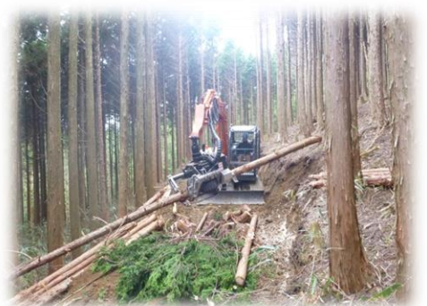
(プロセッサによる枝払・造材作業)
