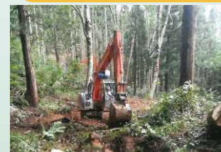
作業道の開設
