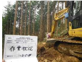
フェラーバンチャー付きバックホウによる作業道開設
