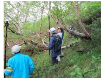
シカ被害協議会等と防護柵の設置(南信署)
