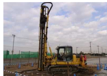
東日本大震災で液状化被害を受けた箇所での実証実験状況
