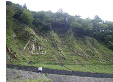
板取川地区（海ノ溝谷施工地） （岐阜署）
