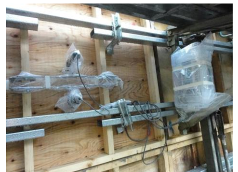
国産材型枠合板を使用した谷止工(左・中)と打設中のたわみ量測定の計器設置状況(右)(富山署)
