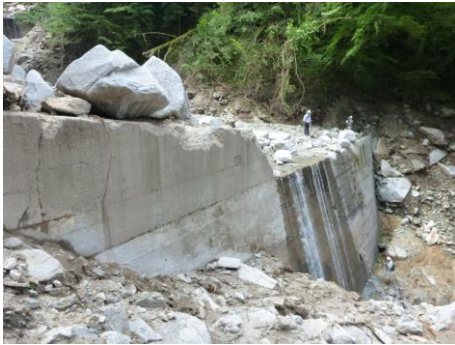
国有林内の治山ダムの被災状況
