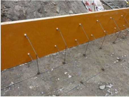
国産材コンクリート型枠合板を使用した谷止工（富山署）
