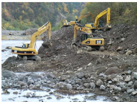
治山ダムにおける緊急的な除石工事の実施（木曾署）
