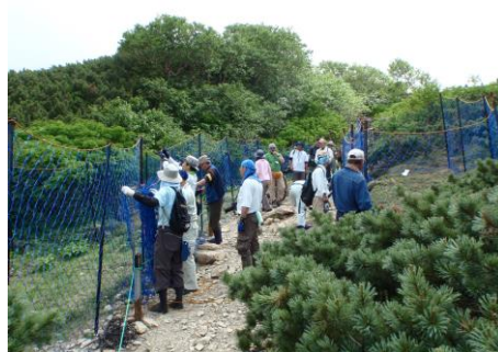
ボランティアによる防護柵の設置 (仙丈ヶ岳馬ノ背:南信署)
