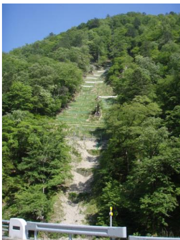
山腹工：直下の国道を保全するため施工した箇所。 (岐阜署)
