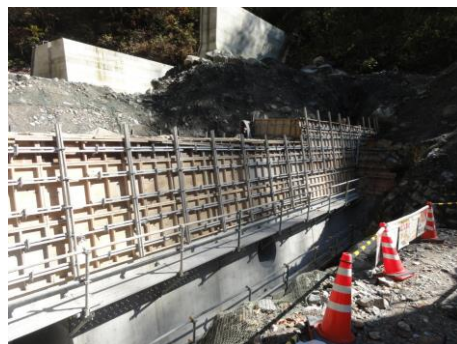
国産材型枠合板を使用した谷止工(左・中)と打設中のたわみ量測定の計器設置状況(右)(富山署)
