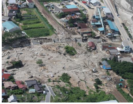
ヘリ調査による市内の被害状況
