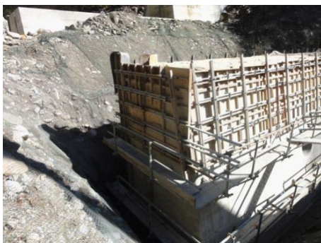
国産材型枠合板を使用した谷止工(左・中)と打設中のたわみ量測定の計器設置状況(右)(富山署)
