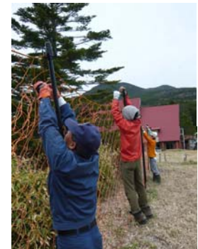
麦草峠での高山植物を保護する 防護柵の設置(東信署・南信署)
