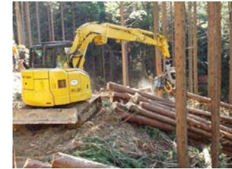
高性能林業機械の活用 (岐阜署)
