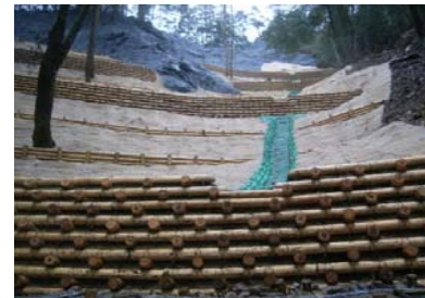
間伐材を利用した土留工 (岐阜署)
