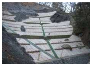
山腹工(伊那谷総合治山)
