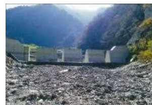
溪間工(スリットダム) (富山署)
