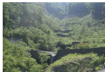
溪間工(鋼製杵ダム) 姫川地区(新潟県・長野県)
