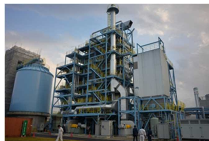
グリーンエネルギー北陸 (富山県射水市)
