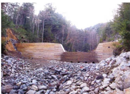
完成した治山ダム 倉本湯川(木曾町)
