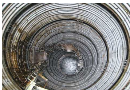
地すべり防止工(集水井) 小渋川地区(長野県)
