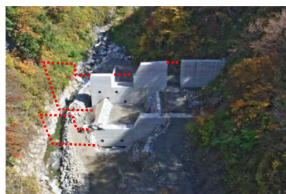
溪間工(施工中の治山ダム) 常願寺川地区(富山県)
