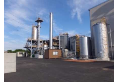
木質バイオマス発電施設 (岐阜県瑞穂市)
