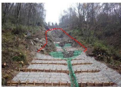
山腹工(丸太筋工と緑化工) 松川入地区(長野県)
