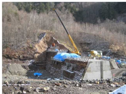
建設中の大型治山ダム 濁川(王滝村)
