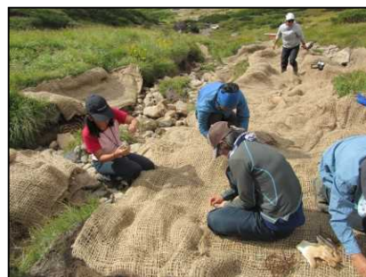
植生ネットの敷設
