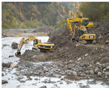
治山ダムの緊急排土工事 濁川(王滝村)
