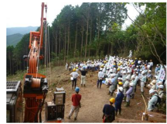
伐採・造林一貫作業システム現地見学会 (愛知所)
