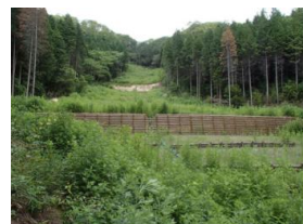
山腹工（木製土留工） (愛知所)
