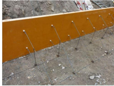
地域材等を使用したコンクリート型枠合板（富山署）
