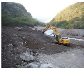
下流への火山灰や土石の流出を防止する緊急対策工事
