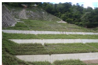
山腹工（岐阜署）
