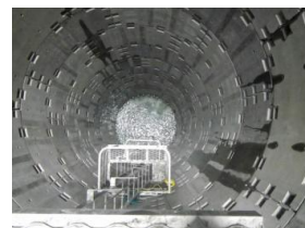
集水井工（中信署）
