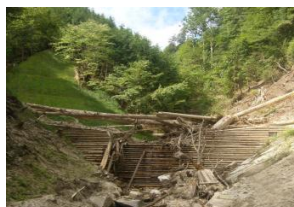
土石流を捕捉した溪間工 (南木曾支署)
