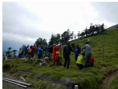
聖岳での防護柵の設置 (南信署)
