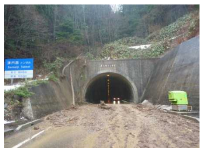
国道256号線の土砂災害 (南木曾支署)
