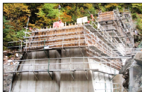
地域材等を利用したコンクリート型枠合板
