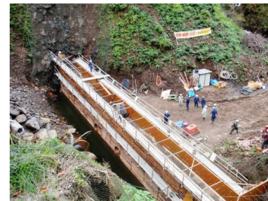
地域材等を使用したコンクリート型枠合板 (中信署)
