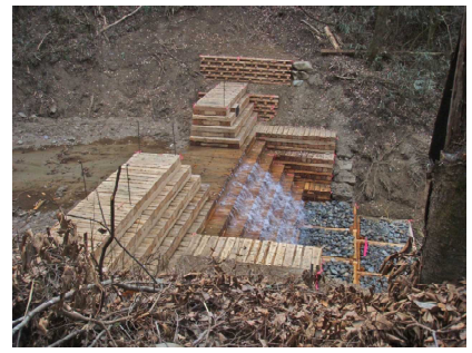
木製治山ダム (南信署)
