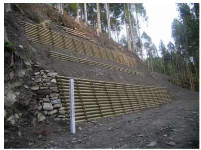
木製校倉式土留工 (愛知所)
