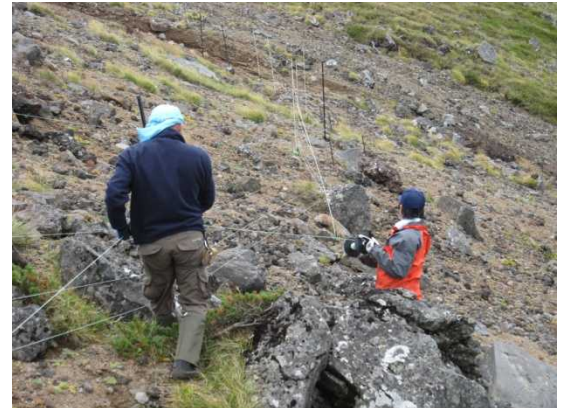
電気防鹿柵の設置：南信署
