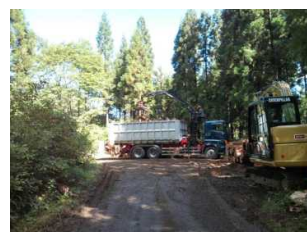
木質バイオマス資材 トラック積込:北信署
