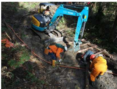
フレキシブルホースを使用した 横断排水溝：中信署
