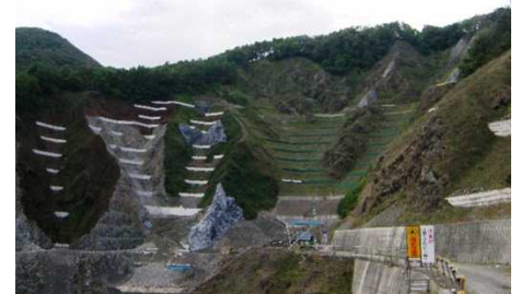
鳶ヶ巣復旧治山工事：伊那谷総合治山
