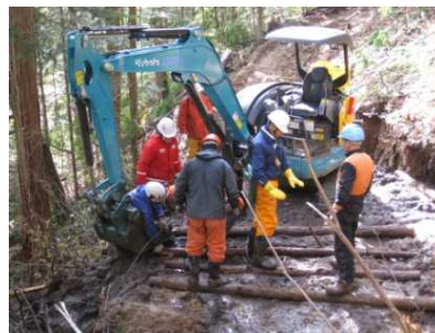
作業道開設の状況：中信署
