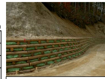
スギの間伐材を利用した法面基礎部の土留工(木曽署)
