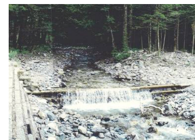
溪流の保全に配慮した工法 (中信署)
