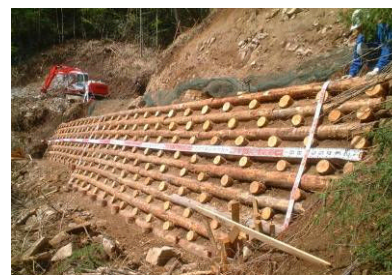
カラマツの間伐材を利用した土留工 (伊那谷総合治山事業所)
