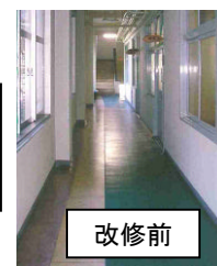
廊下壁面の木質化 (局庁舎)
