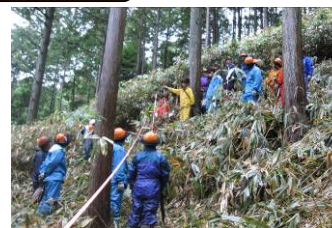
作業道作設の現地検討会(東濃署)
