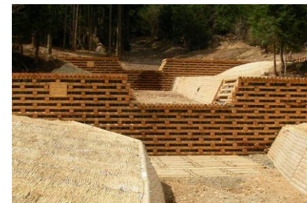
木製谷止工と護岸工の施工(岐阜署)
