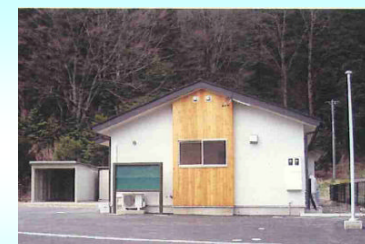
合法木材の使用による庁舎の新築(東信署)
