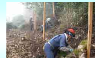
シカ防護柵の設置(木曾署)
