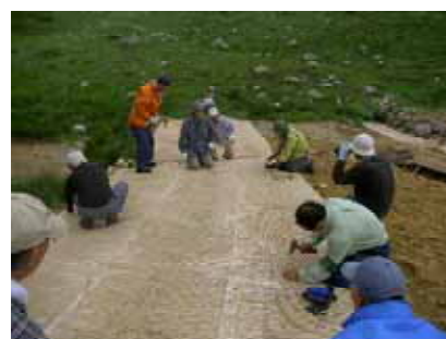
北アルプス双六池周辺で池への土砂流入防止のための自然分解性のネット張り作業( H18 )
