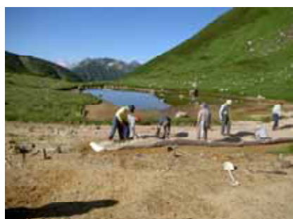
北アルプス双六池周辺で池への土砂流入防止のための自然分解性のネット張り作業( H18 )
