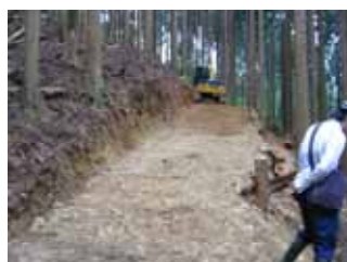
作業道の開設
