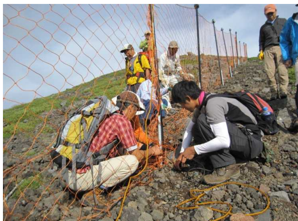
ニホンジカ防護柵の設置：南信署
