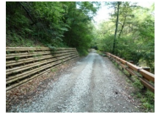
木製ガードレール等の設置 場所：長野県北佐久郡軽井沢町 ながくらやま 長倉山国有林 東信森林管理署
