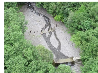
流木対策の実施（流木捕捉工） （中信署）
