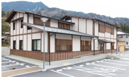
庁舎の新築(南木曾支署)
