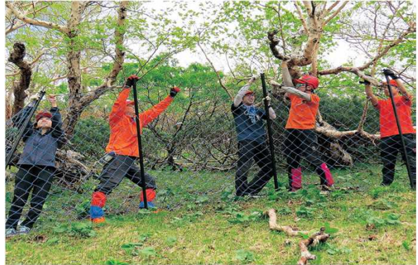
標高2,700m付近での防護柵の設置 (南アルプス仙丈ヶ岳)
