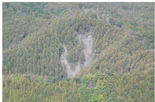
角間山国有林の状況(長野県上田市)
