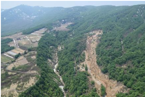
山腹崩壊(源頭部)の状況
