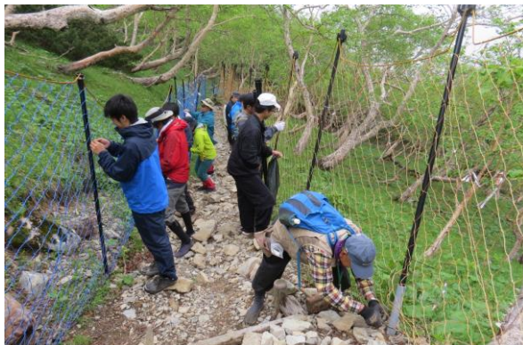
ボランティアの協力による防護柵の設置 (南アルプス仙丈ヶ岳 標高2,600m付近)
