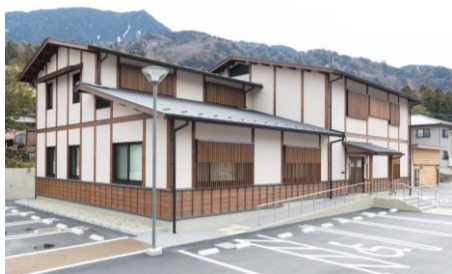
南木曾支署(新築)
