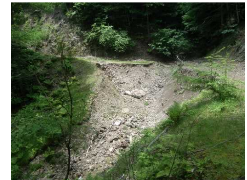
路網整備事業（林道改良工事）
