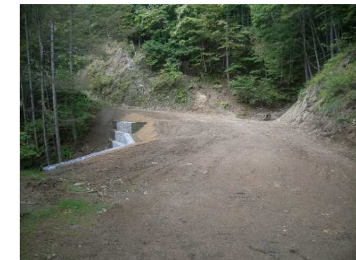
令和3年度 南信森林管理署 西谷林道改良工事
