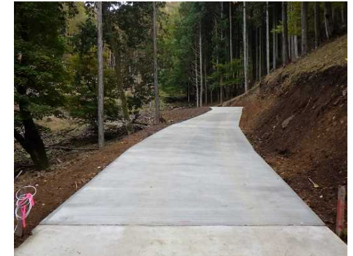
令和3年度 南信森林管理署 観音沢林業専用道特殊修繕
