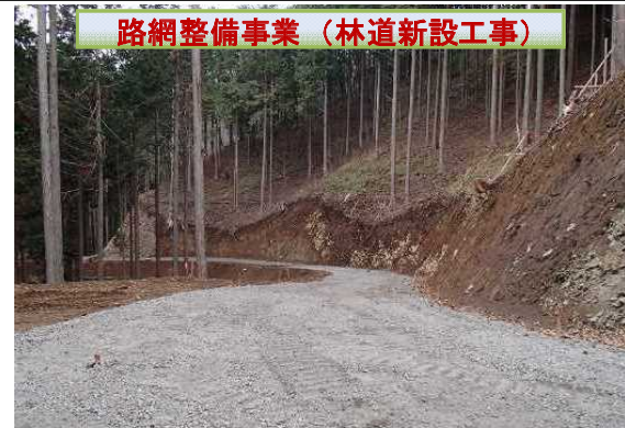
平成26年度 南信森林管理署 観音沢林業専用道新設工
