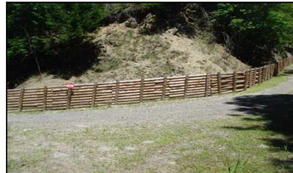
平成29年度 南信森林管理署 星ヶ塔林道改良工
