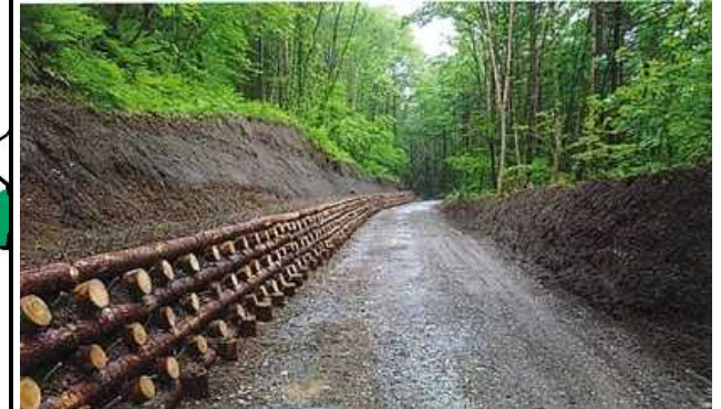
平成28年度 東信森林管理署 長倉山林道改良工事
