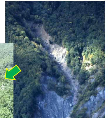
蒲原沢 荒廃状況
