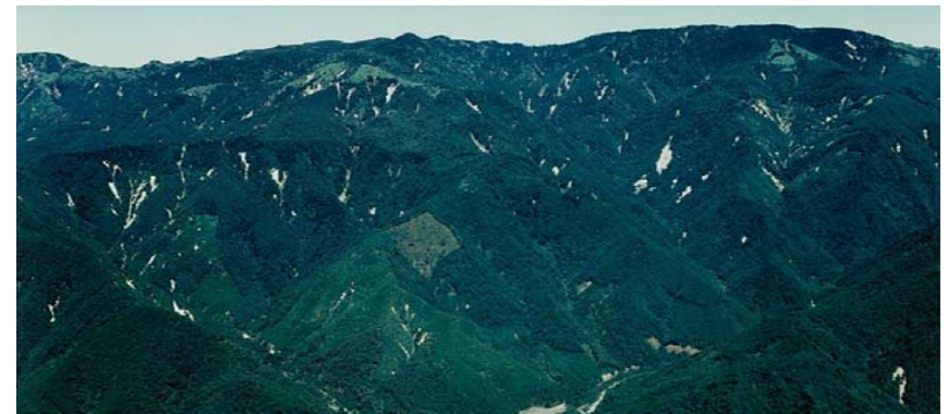
荒廃状況(全景)
