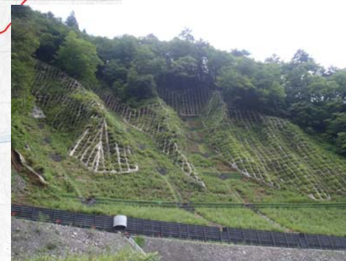
海ノ溝谷区域 山腹工（施工後）
