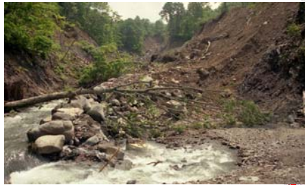
木地屋川 溪間工
