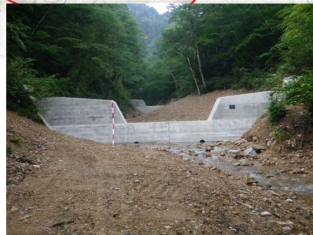
大ツゲ谷区域 溪間工（施工後）
