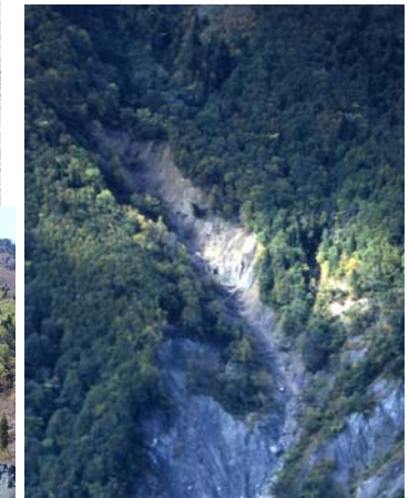
蒲原沢 山腹工
