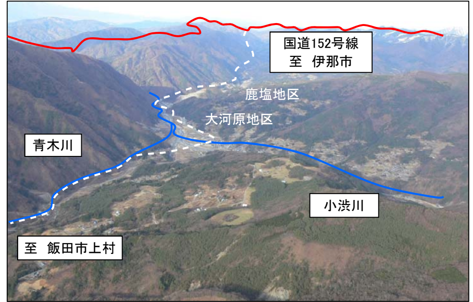
保全対象(北部)
