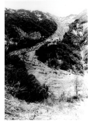
山之坊 山腹工
