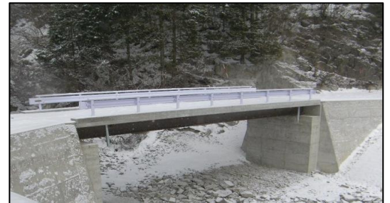
東濃森林管理署 夕森田立(丸野)橋梁架設工事
