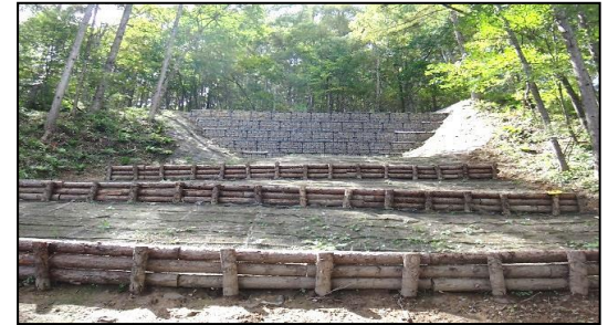
東信森林管理署 大門西林道改良工事
