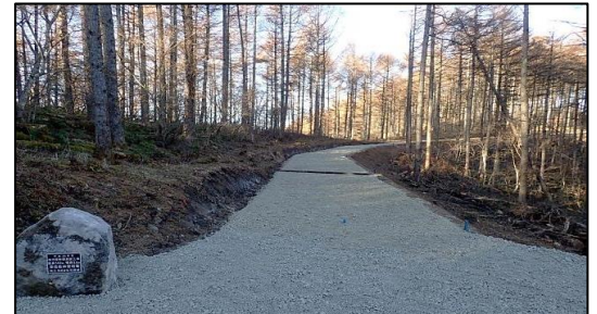
東信森林管理署 四方原林道新設工事
