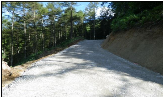
南信森林管理署 兀嶽林道新設工事
