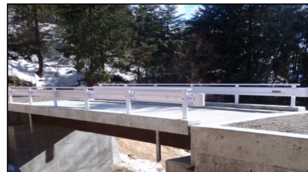
平成26年度 東濃森林管理署 夕森田立(丸野)橋梁架設工事
