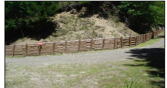
平成29年度 南信森林管理署 星ヶ塔林道改良工事
