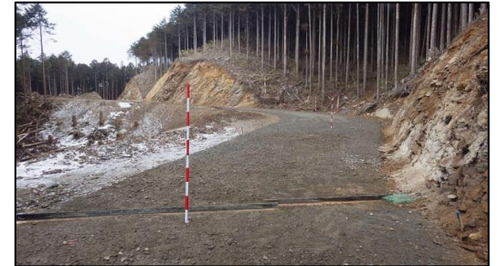
平成28年度 愛知森林管理事務所 胡麻沢林業専用道新設工事
