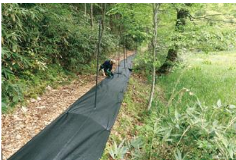
防草シートの張り替え作業
