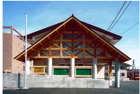
国産材を使用した北信森林管理署庁舎 (平成19年度新築)
