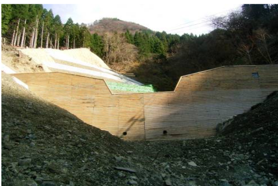
木製型枠を使用した谷止工
