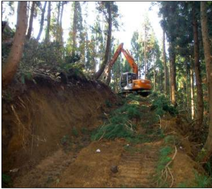
作業路の開設
