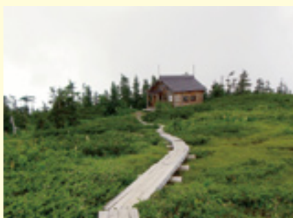
避難小屋が整備された奥千町ヶ原
