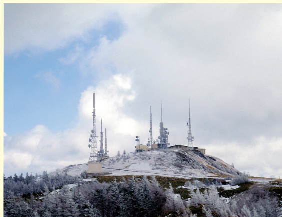
王ヶ頭付近の電波塔群
