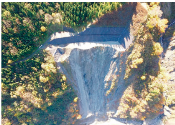
蒲原沢復旧治山工事箇所
