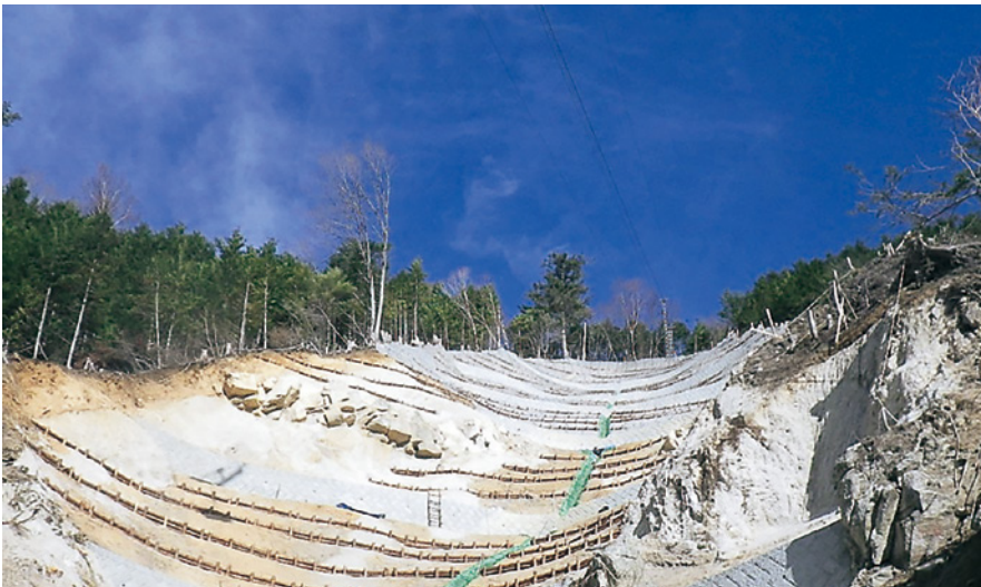
施工途中の現場の様子
