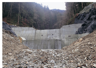
新設された治山ダムの一基
