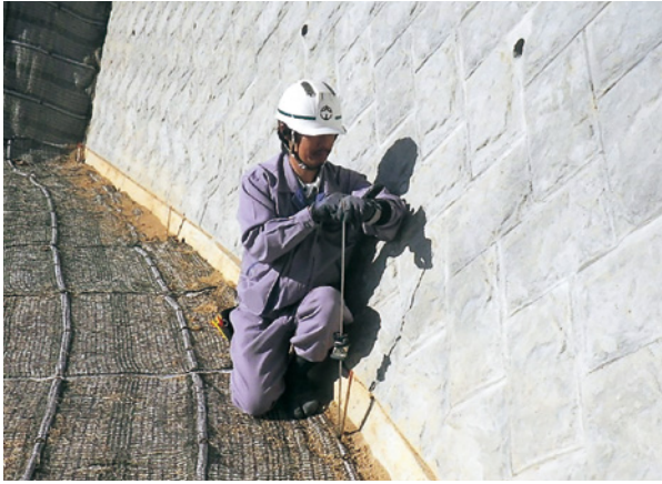
自動追尾測量器を用いてワンマン測量をしている平栗さん
