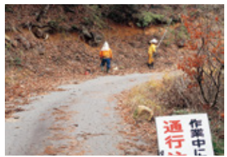
トラック運材等に支障になる灌木の除去
