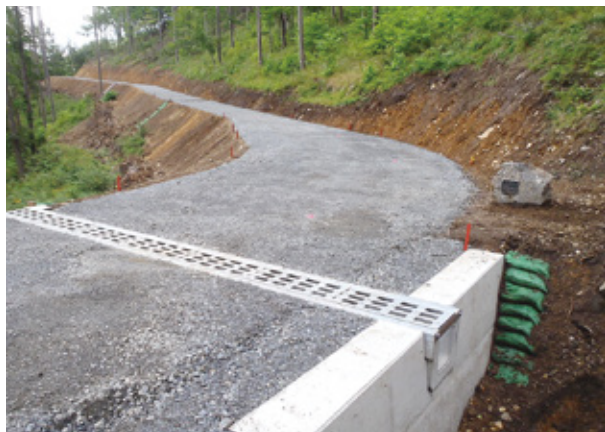
完成した林業専用道
