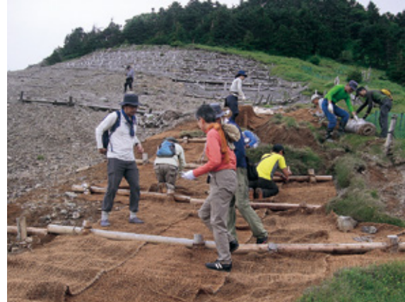
植生マット（ヤシマット）設置
