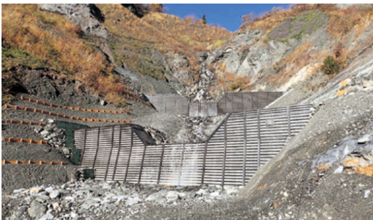
鋼製枠床固工
