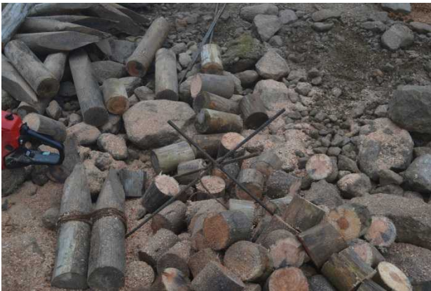
①不要となった筋工の丸太を切断
