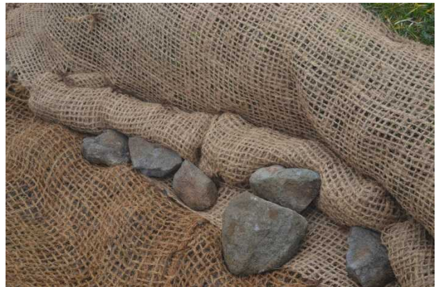
④オーバーハング状の崖部なのに密着させる
