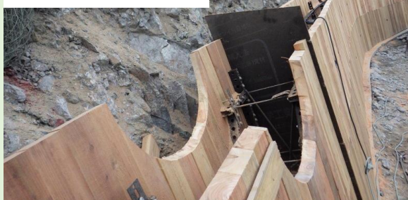
平割材型枠設置状況
