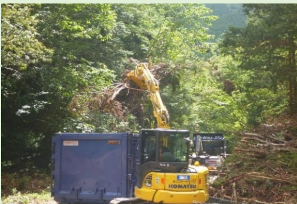
運搬車への積込み状況
