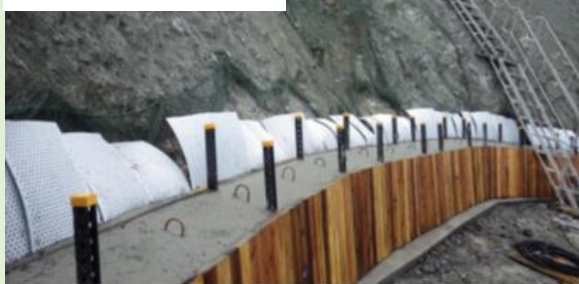
コンクリート打設状況
