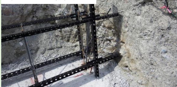
軽量フレーム設置状況
