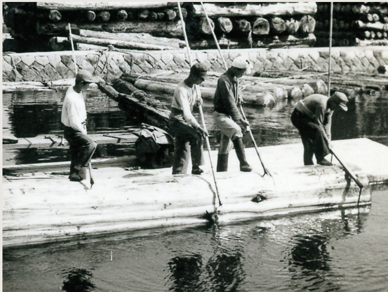
昭和31年頃、水上での丸太の計測(検知)作業
