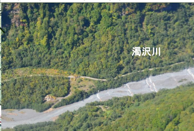
上空写真 緊急除石対策工事箇所の状況
