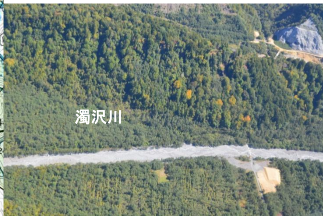
上空写真 濁沢川中流の状況
