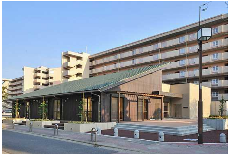
県営鳴海住宅集会所（愛知県名古屋市）
