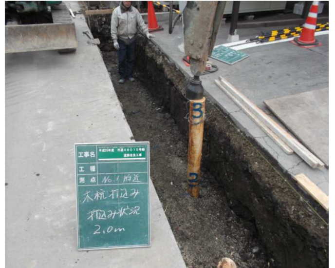
道路改良事業側溝の打設
