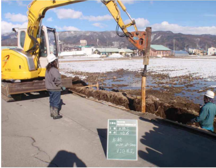
農業用水路の打設
