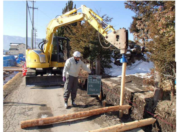
道路改良事業側溝の打設
