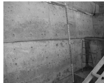
写真-14 コンクリート表面
