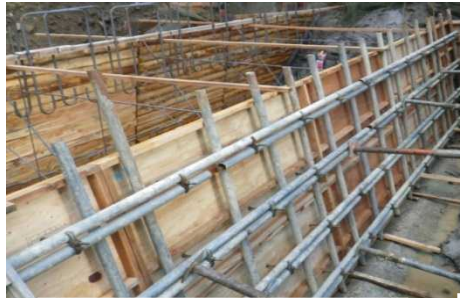
写真-3 単管による支保工
