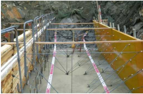
写真-2 型枠の立ち上げ
