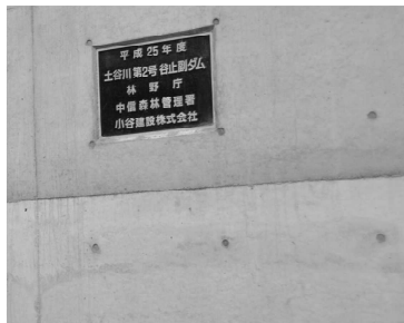
写真-12 打継目の段差
