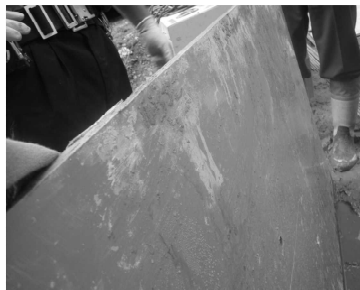
写真-13 脱型後の型枠合板
