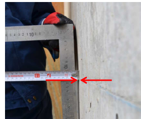
写真-7 表面のはらみ
