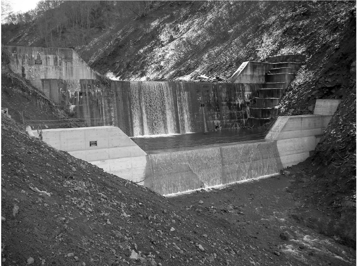
写真-20 工事完成写真（工事名：平成25年度 土谷川地すべり防止工事）
