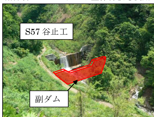
写真-1 治山ダム施工箇所
